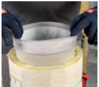
Bild 8a: Montage mit Gewebedichtung (15) (optional): Aufstecken auf die Rohrspitze
