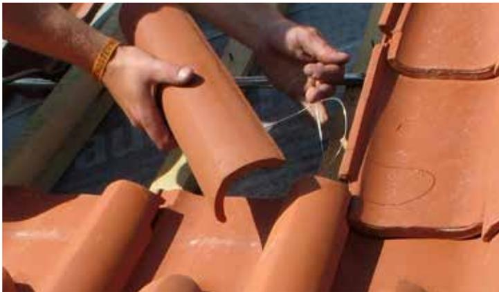
Zur Sturmsicherheit von Mönch- und Nonnenkegeldächern ist jeder Mönchziegel mit korrosionsbeständigem Bindedraht zu fixieren.
