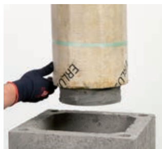
Bild 8b: Montage mit Gewebedichtung (15) (optional): Einsetzen der Edelkeramikrohrs
