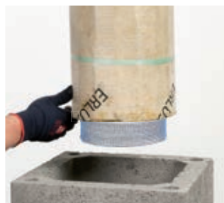
Bild 8b: Montage mit Gewebedichtung (15) (optional): Einsetzen der Edelkeramikrohrs
