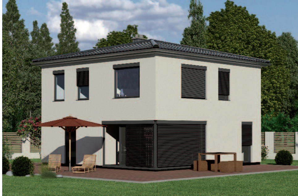
Une esthétique cube, un débord de toiture réduit
